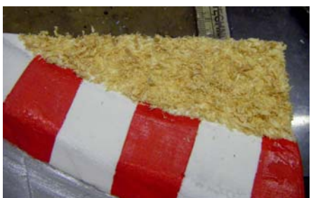
Savsmuld påført og jævnt fordelt!
